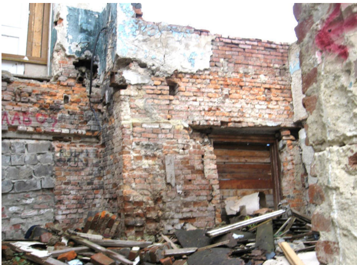
Фрагмент внутреннего состояния здания хозпостроек.
