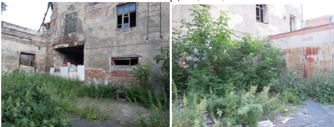
Рис.39. Объект культурного наследия регионального значения «Хозпостройки (перестроены)» (Свердловская область, г. Екатеринбург, ул. Октябрьской революции, 33а). Слева – поздняя вставка для объединения двух объемов. Справа – пристроенные к бывшему зданию складов гаражные боксы. Общие виды с внутриворотовой территории. Фото Т.С. Старцевой, июнь, 2021 года.
