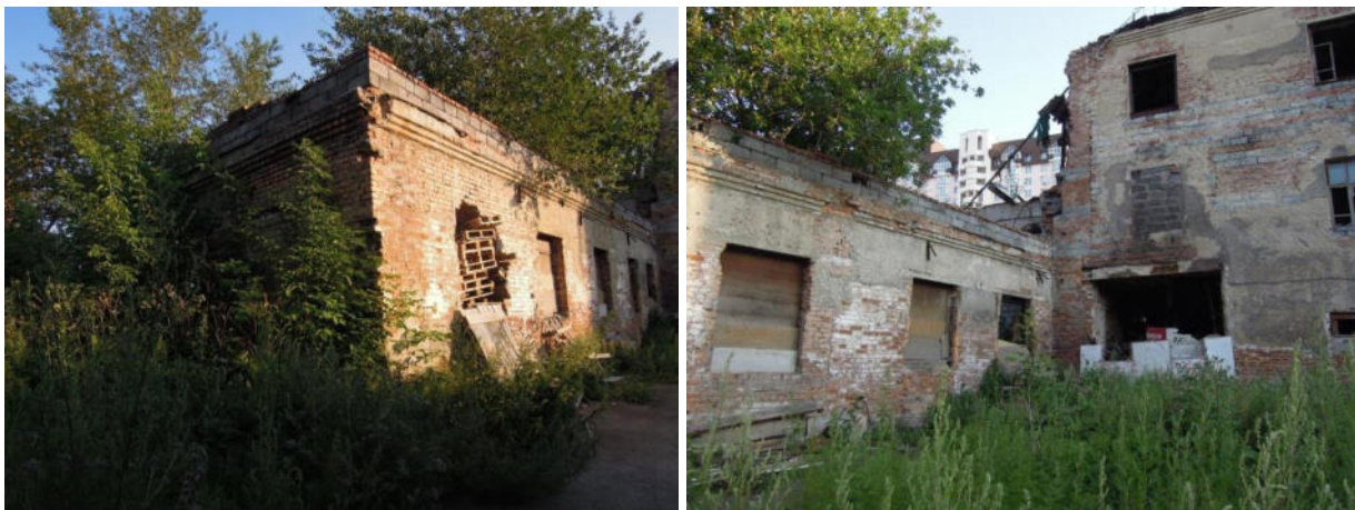
Рис.38. Объект культурного наследия регионального значения «Хозпостройки (перестроены)» (Свердловская область, г. Екатеринбург, ул. Октябрьской революции, 33а). Общие виды дворовых фасадов одноэтажного объема бывшего завода фруктовых вод с внутриворотовой территории. В 1950-е годы был надстроен двумя этажами, к 2001 году второй и третий этажи снесены. Крыша и перекрытия отсутствуют. Фото Т.С. Старцевой, июнь, 2021 года.
