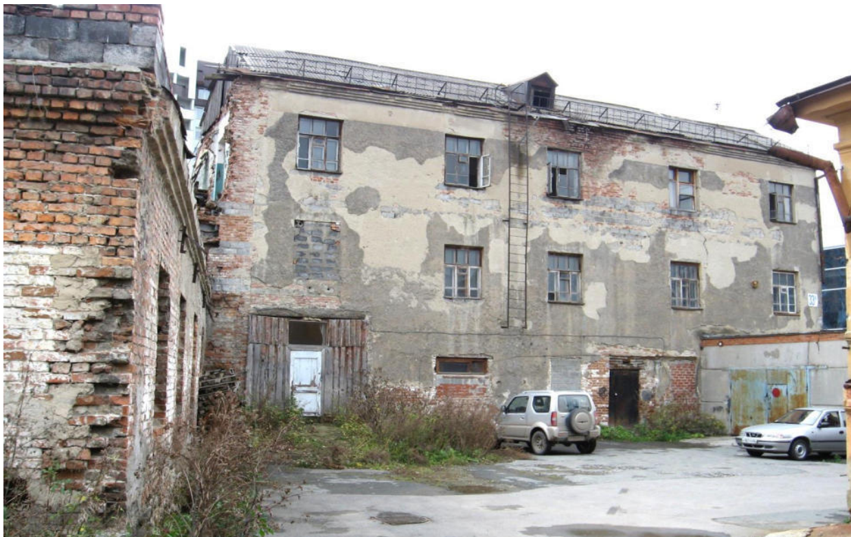
Северный фасад перестроенных хозпостроек (вид с дворовой территории)
