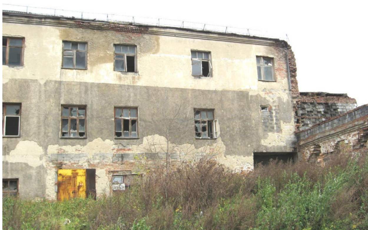
Фрагмент здания хозпостроек. Вид с юга.
