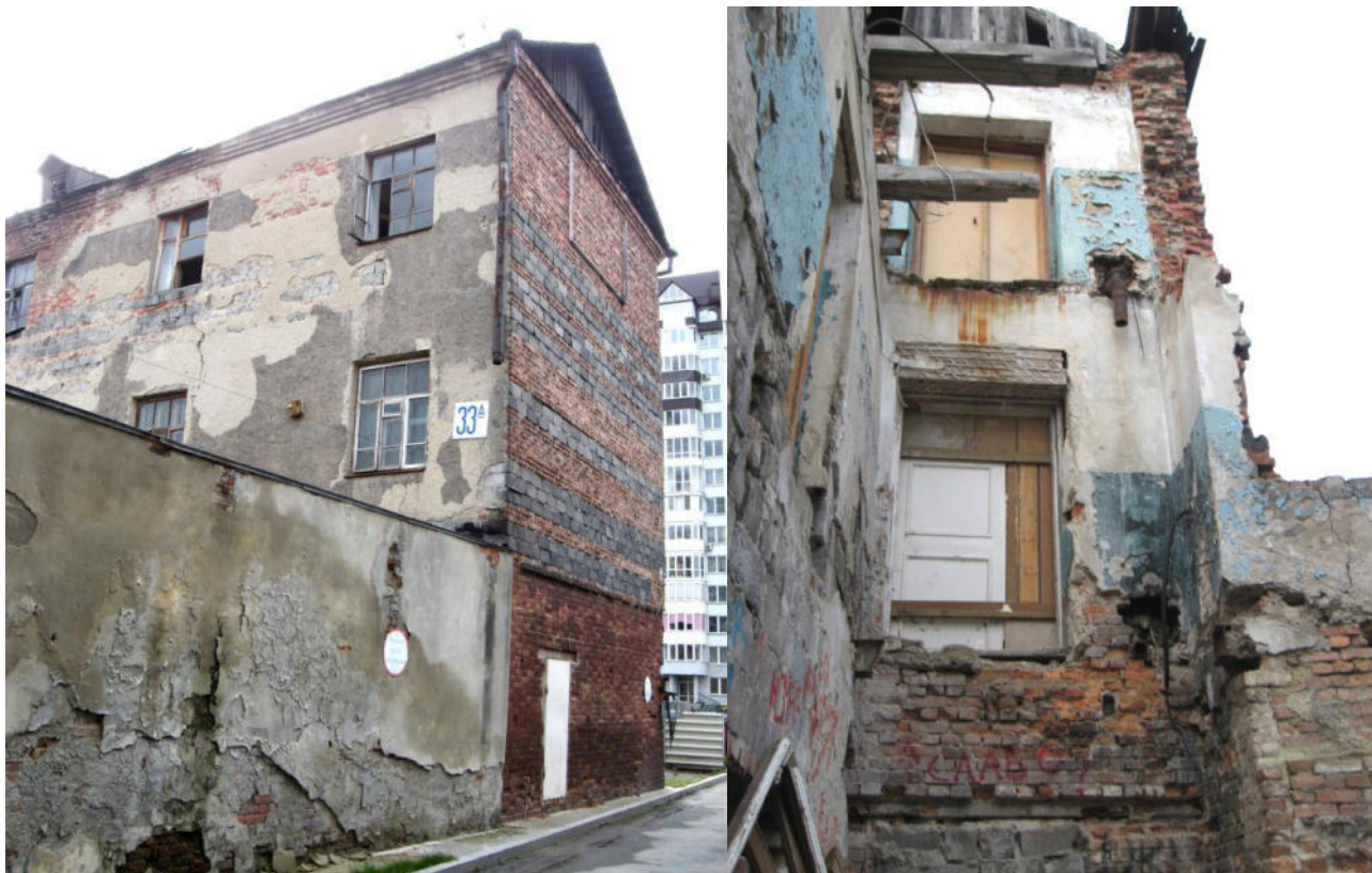
Фрагмент юго-западного фасада здания хозпостроек и состояния интерьера.
