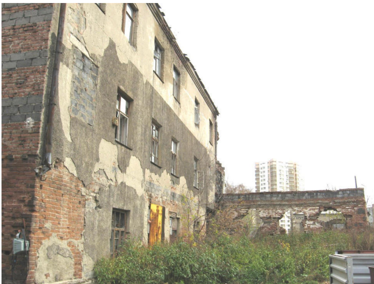
Северо-западная торцевая здания хозпостроек и фрагмент кирпичной ограждающей стены. Вид с севера.
