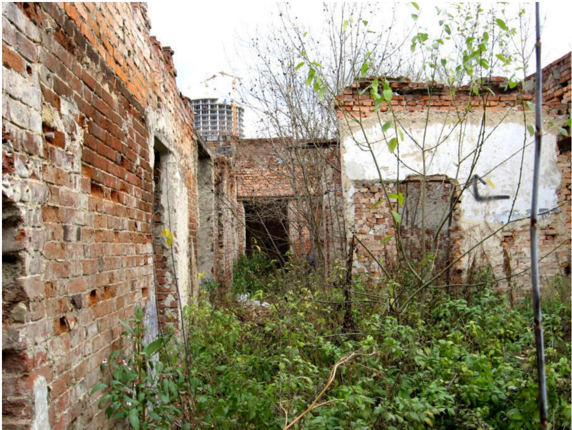
Фрагмент внутреннего состояния здания хозпостроек
