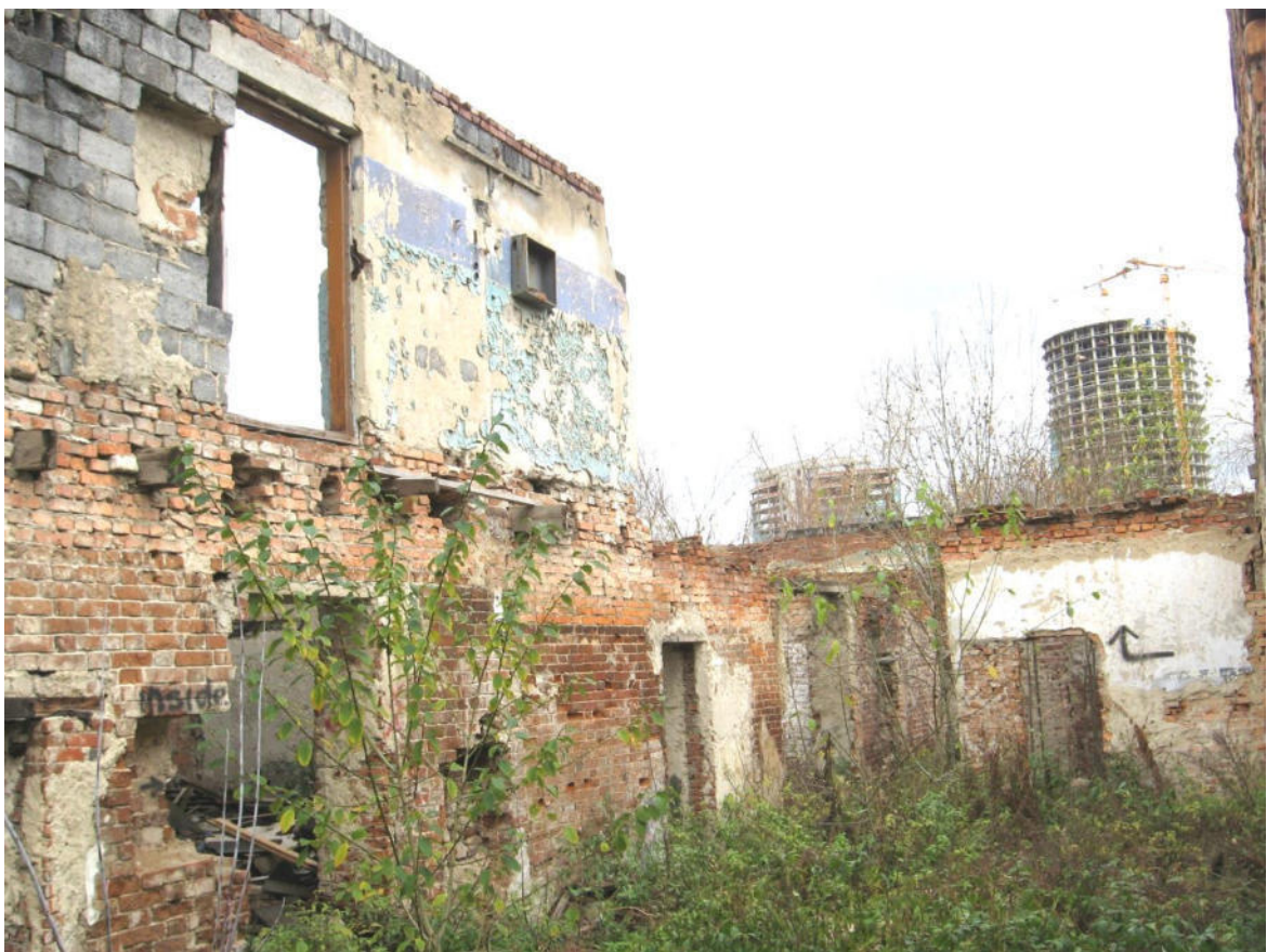
Фрагмент внутреннего состояния здания хозпостроек
