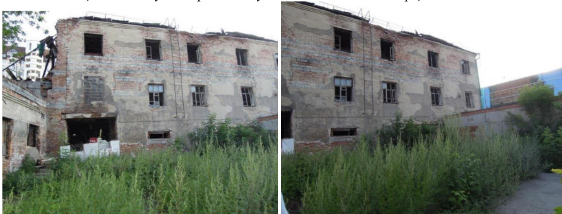
Рис.37. Объект культурного наследия регионального значения «Хозпостройки (перестроены)» (Свердловская область, г. Екатеринбург, ул. Октябрьской революции, 33а). Общие виды дворовых фасадов трёхэтажного объёма (бывшее одноэтажное здание складов) с внутривортовой территории. Фото Т.С. Старцевой, июнь, 2021 года.
